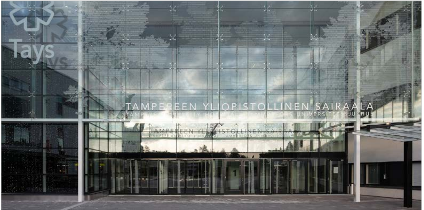
Tampereen yliopistollisen sairaalan lasipilareilla varustettu lasiverhous
