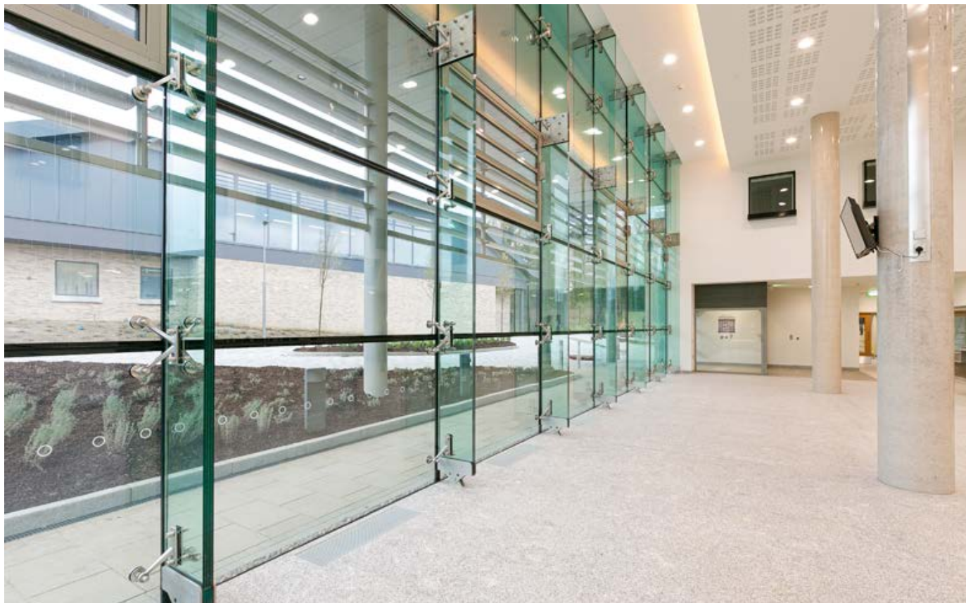
National Forensic Mental Health Servicen lasipilareilla varustettu lämpöeristetty julkisivu
