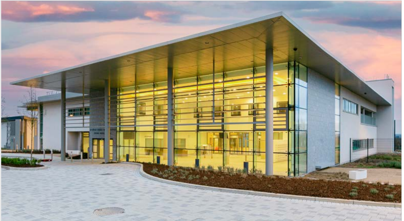
National Forensic Mental Health Services lasipilareilla varustettu lasijulkisivu
