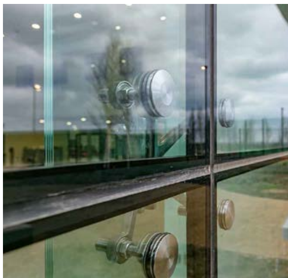
National Forensic Mental Health Servicen lasipilareilla varustettu lämpöeristetty julkisivu
